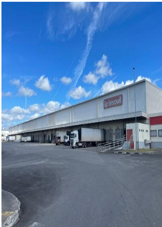
Centro de distribuição
