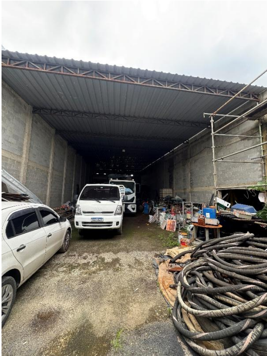
Vista da garagem do galpão
