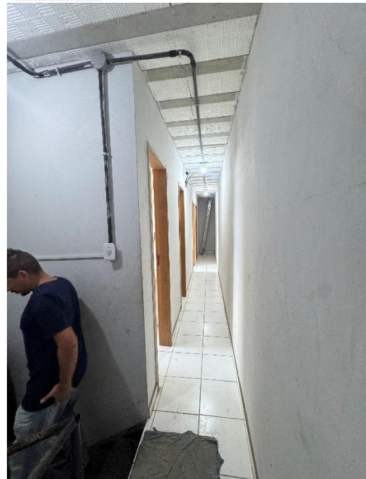
Vista do corredor do segundo andar do galpão
